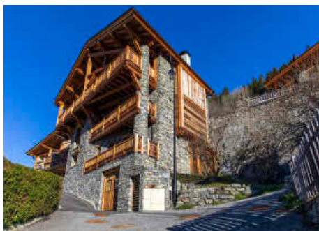
TÍPICAMENTE ALPINO. Exterior del chalet, originalmente edificado en el siglo XVIII.
